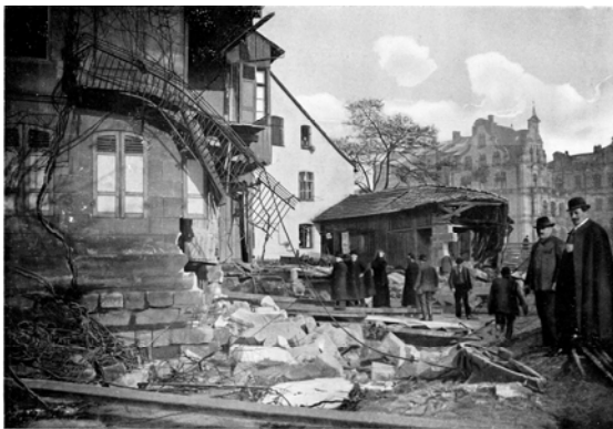
Eingestürzte Häuser. Kleinweidenmühle.
